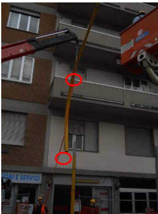
**Figura 6: Situazione conforme: evidenza punti di legatura per movimentazione frusta**
